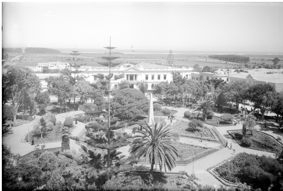
Figura 3. Imagen tomada desde las alturas de la catedral de La Serena, ubicada en calle Cordovez con Los Carreras. La cámara está orientada de oriente a poniente mirando el mar. Fotografía realizada en 1920 aproximadamente. Datos de la pieza: Placa de vidrio emulsión gelatina bromuro de plata 10x15 cm. Fuente: Archivo Fotográfico Zoilo Puerta Roldán, Museo Arqueológico de La Serena. Nombre del archivo: caja 5-no.52.tif. Fotógrafo Zoilo Puerta Roldán.
